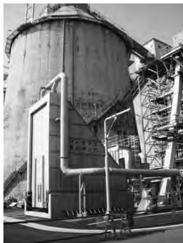
西条発電所の石炭サイロ
